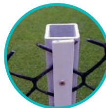
Fixation du grillage sur le poteau à l'aide d'une contre latte
