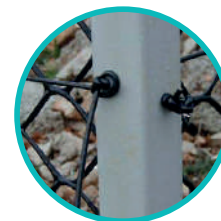
Mise en place des fils de tension sur les poteaux
