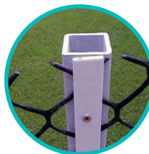
Fixation du grillage sur le poteau à l'aide d'une contre latte
